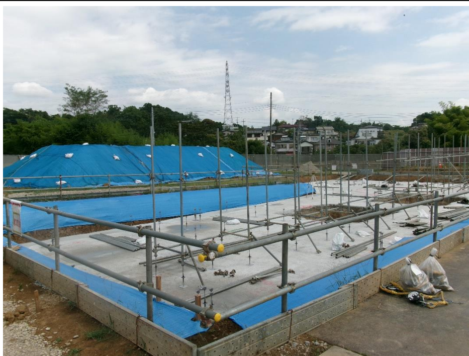
敷地 南西より撮影【令和7年8月下旬】
