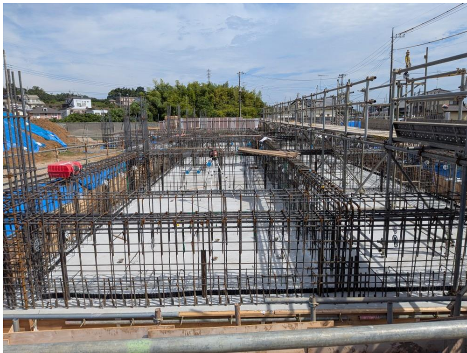
敷地 西より撮影【令和7年9月下旬】
