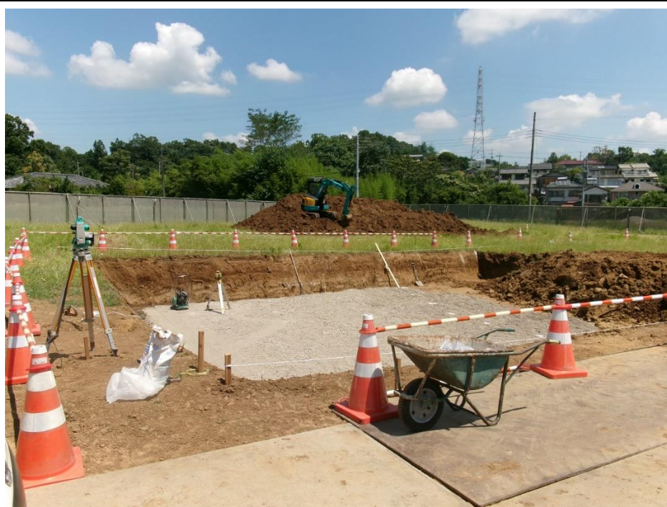
敷地 南西より撮影【令和7年7月下旬】
