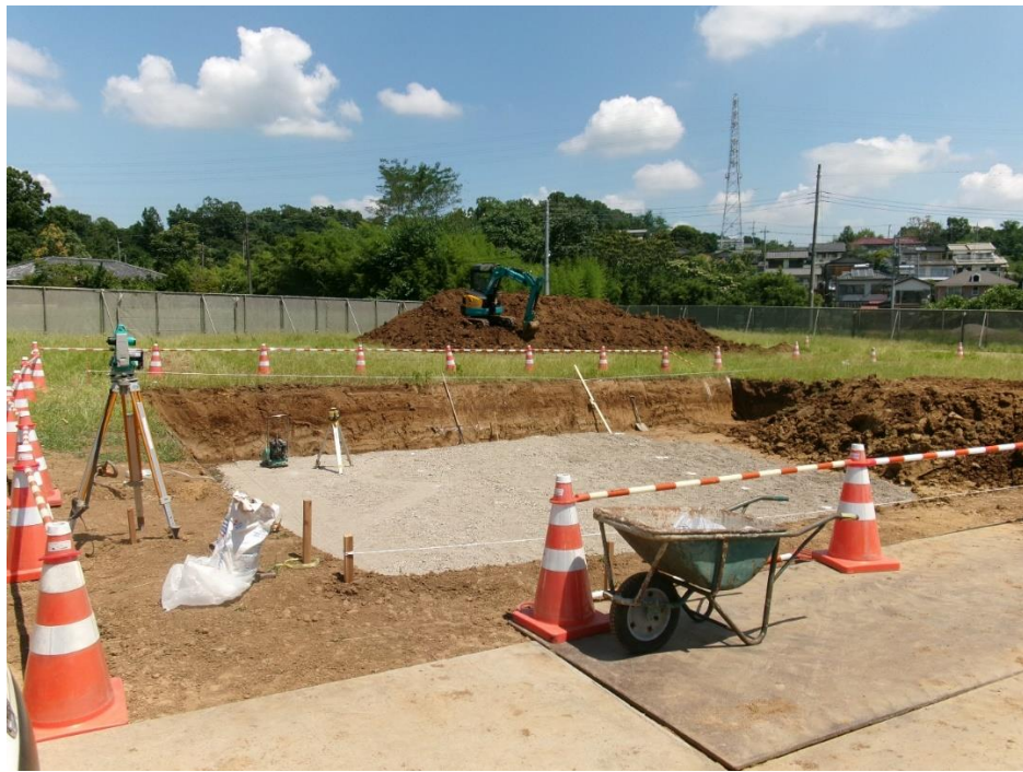
敷地南西より撮影【令和7年7月下旬】
