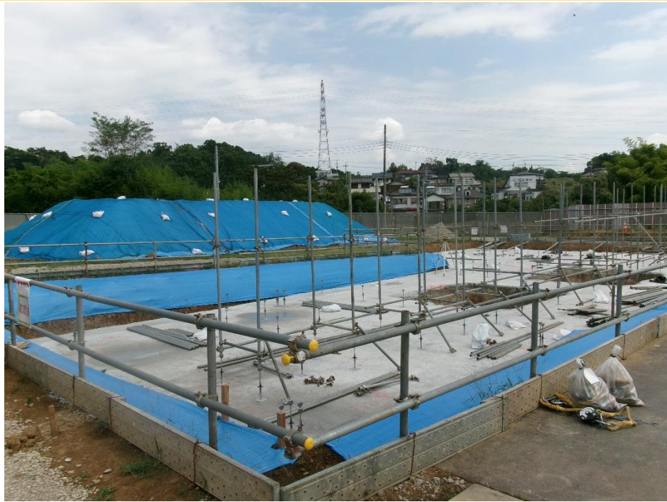
敷地南西より撮影【令和7年8月下旬】
